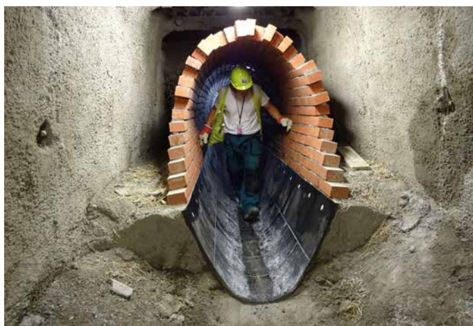
▲ Obr. 9 Ražená část odtokové stoky
