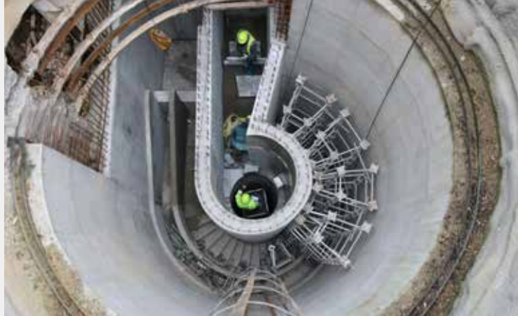
▲ Obr. 7 Osazování kamenů v místě nátoku
