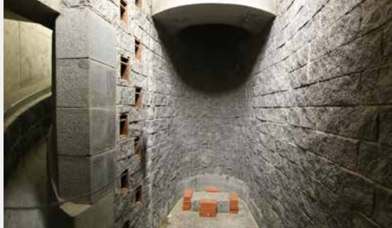
▲ Obr. 8 Rozrážecí práh
