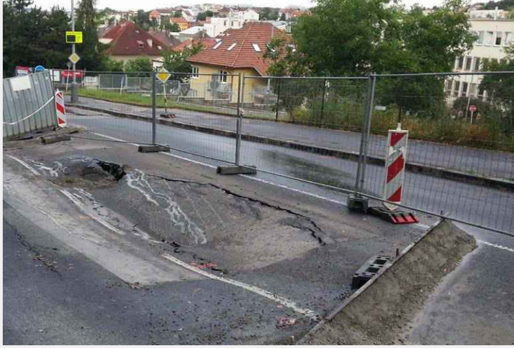
▲ Obr. 3 Propad povrchu
