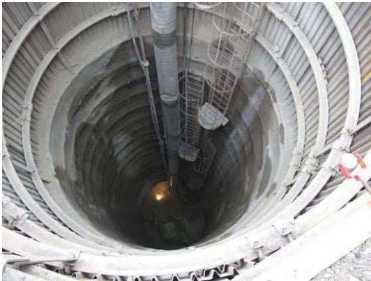
Obr. 4 Poddajná konstrukce šachty
