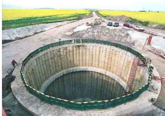
Obr. 5 Tuhá konstrukce šachty [12]
