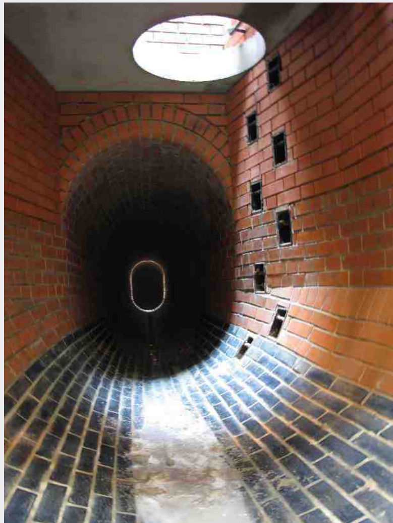
▼ Obr. 5. Propoj do stoky K v komoře (profil 1200/1800 mm)
