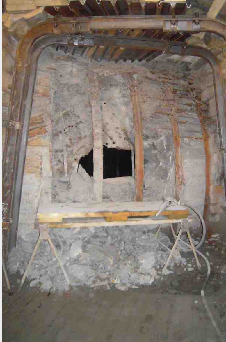
▲ Obr. 10. Výstavba propoje do stoky K
