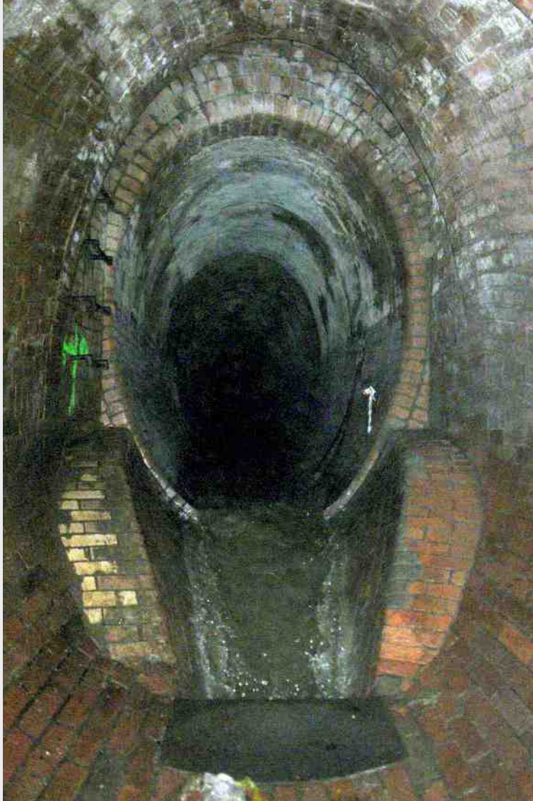
▲ Obr. 2. Původní odlehčovací komora, tzv. žabí tlama
