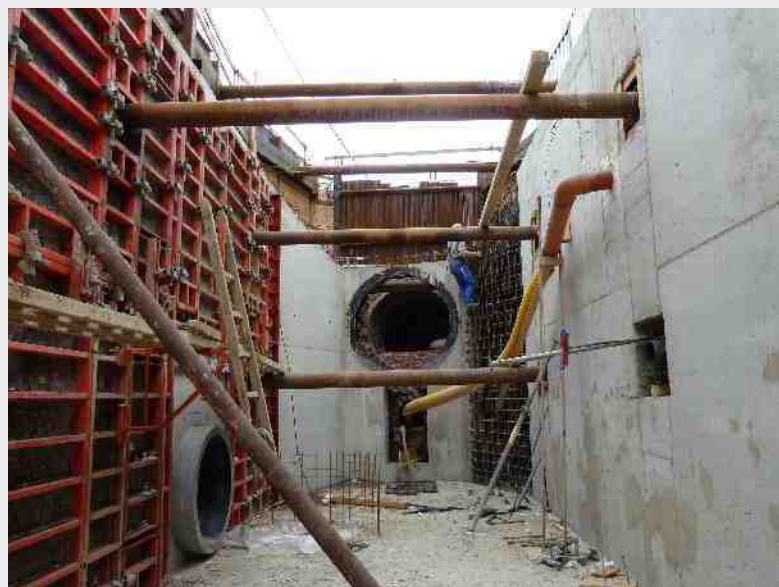
▼ Obr. 8. Betonáž stěn
