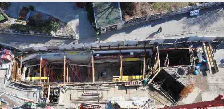
▼ Obr. 7. Stavební jáma
