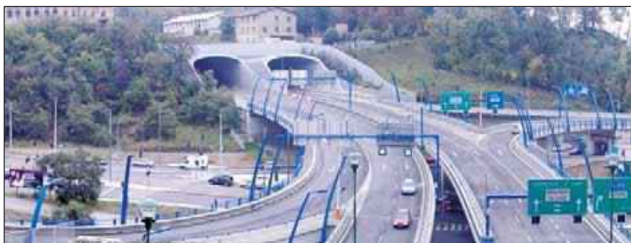
Obr. 2 Pohled na jižní portál Strahovských tunelů Fig. 2 A view of the southern portal of the Strahov tunnels
