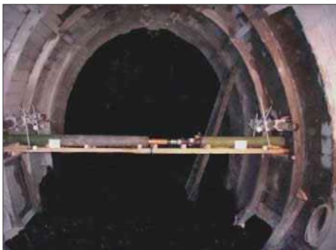
Obr. 5 Rozpěrná statická zatěžovací zkouška použitá pro zjištění reálných hodnot modulu přetvárnosti drenážní šterkové vrstvy v ostění odvodňovací štoly
