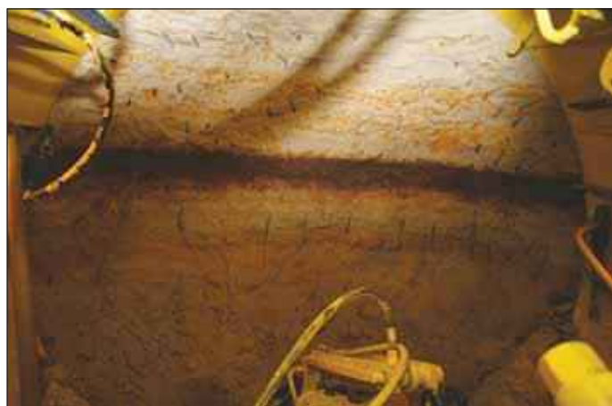
Obr. 3 Čelba tunelu, křemičité pískovce s polohou zpevněnou železitým tmelem (Bc. Petr Cupal) Fig. 3 Tunnel excavation face – quartzose sandstone with the layer solidified by ferriferous cement (Bc. Petr Cupal)
