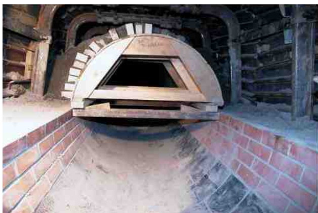
Obr.11 – Osazení ramenátu
