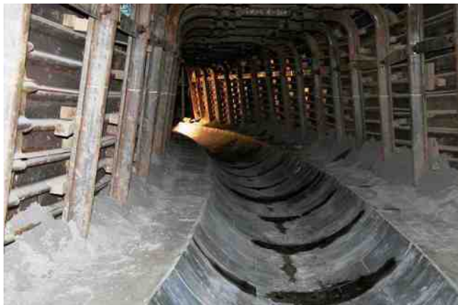
Obr.9 – Uložení žlábků z čedičových radiálek
