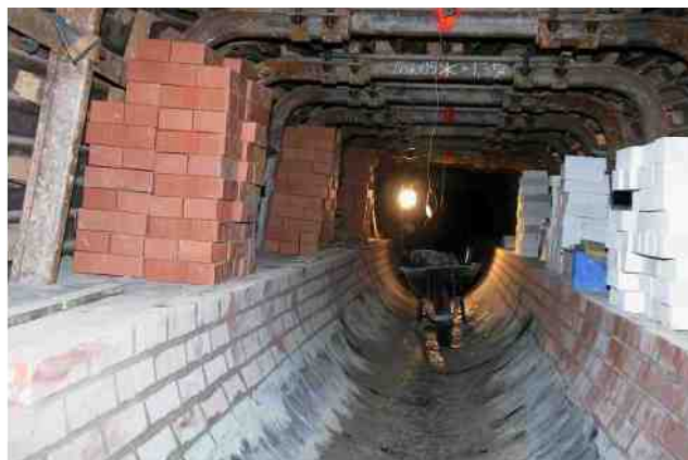
Obr.10 – Vyzdění boků stoky
