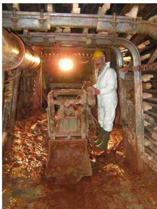
Obr. 6 – Ražba v zvodnělých jílovitých břidlicích
