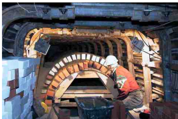
Obr.12 – Zdění horního pasu stoky
