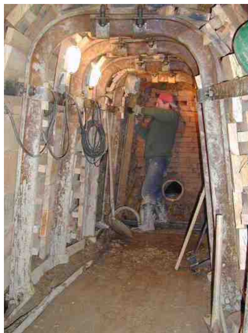
Obr. 4 – Poddajná ocelová výztuž obr. 5 – Štola s použitím poddajné výztuže
