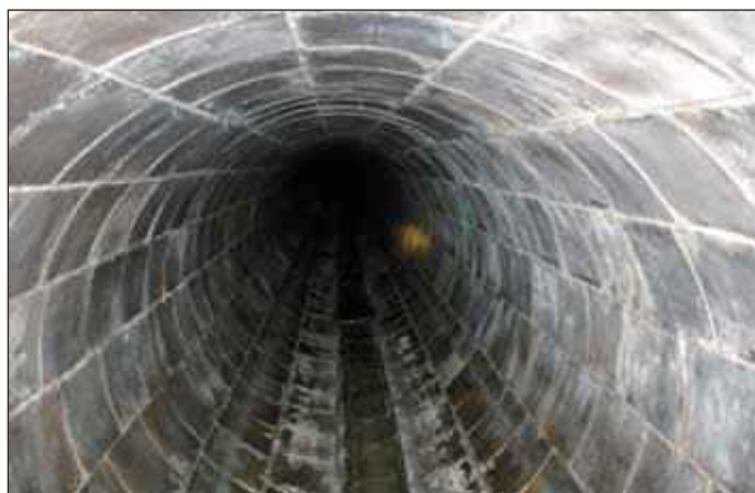
Obr. 2 Stávající stav Fig. 2 Existing condition
