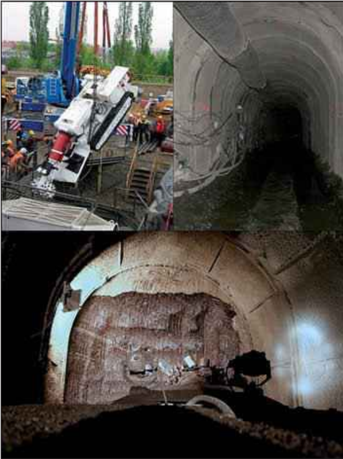
Obr. 4 Fotografie z provádění stavby Fig. 4 A pictures from the excavation period
