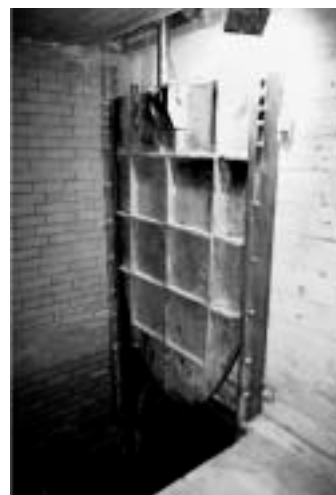
Obr. 4: Šoupě – pohled z první úrovně
