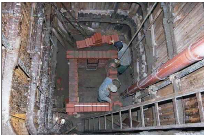
Obr. 1 Šachta vyztužená ocelovou důlní výztuží Fig. 1 Shaft reinforced with steel colliery support
