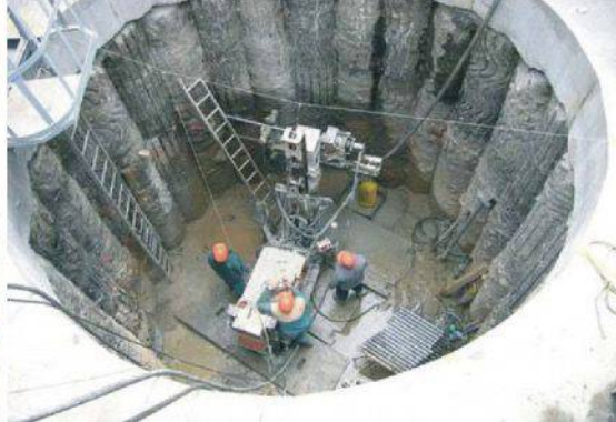
▲ Příklad tuhé konstrukce: šachta z předvrtávaných pilot
