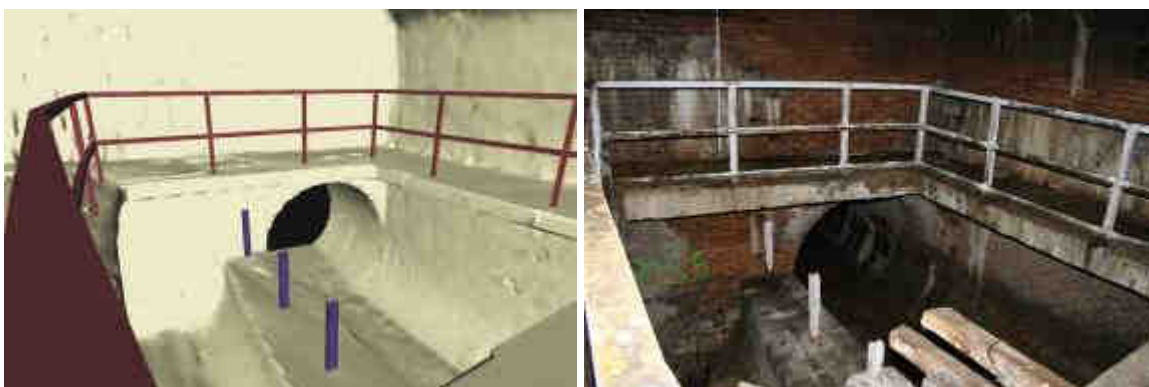
Obr. 3 – porovnání vytvořeného povrchového 3D modelu (vlevo) a fotografie (vpravo)
