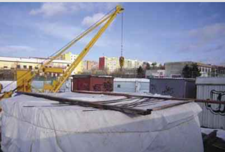
▲ Obr. 8. opatření pro betonáž v zimním období
