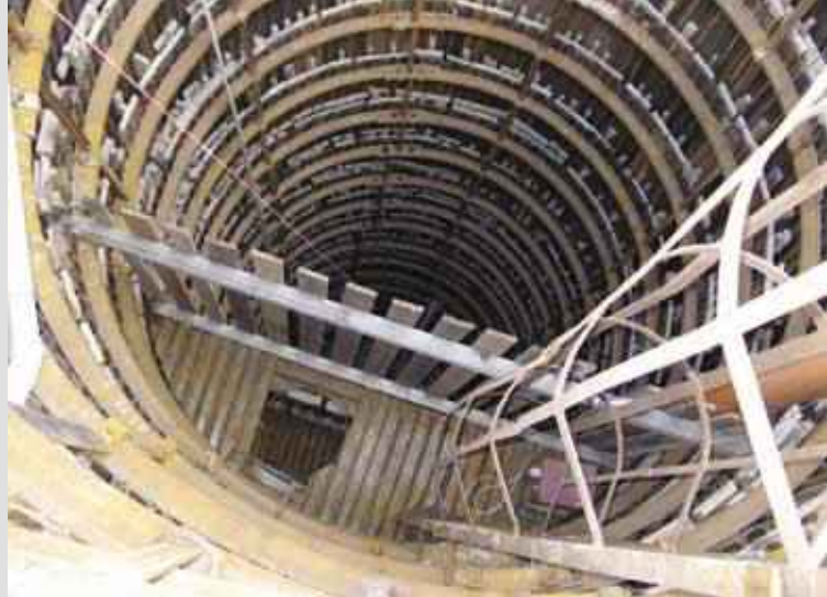
▲ Obr. 3. Provizorní konstrukce šachty.
