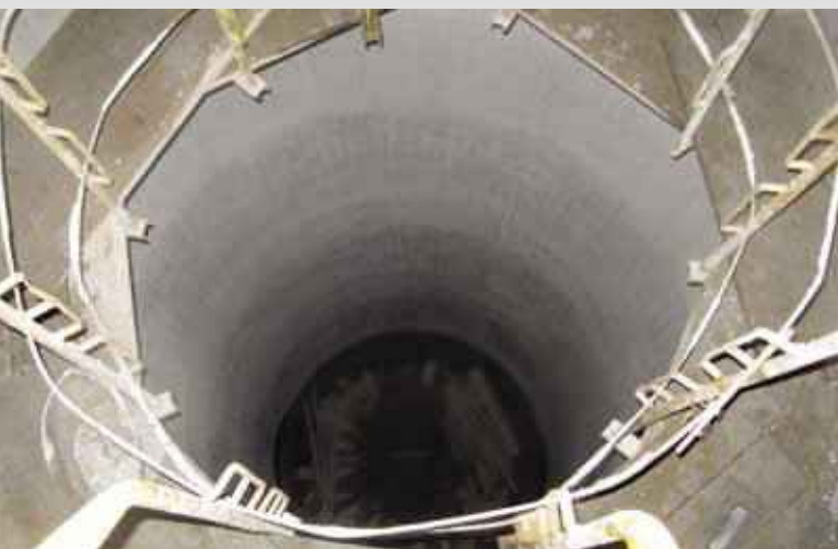
▼ Obr. 10. Druhá plošina šachty je určena k finální povrchové úpravě již hotové betonové konstrukce
