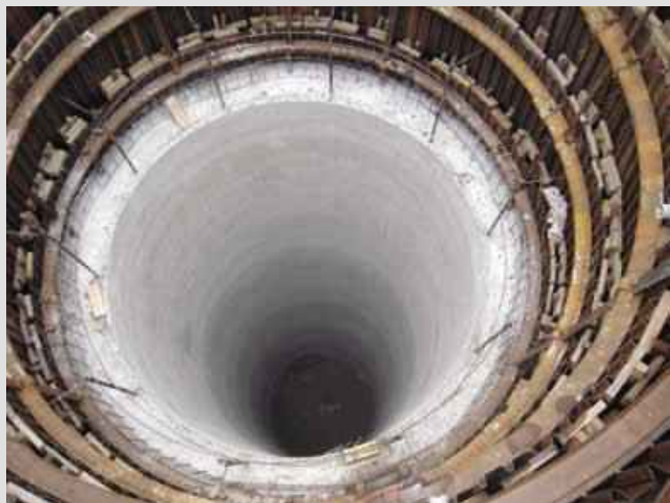
▲ Obr. 4. Definitivní konstrukce šachty.
