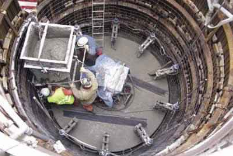
▲ Obr. 7. Ukládání betonové směsi
