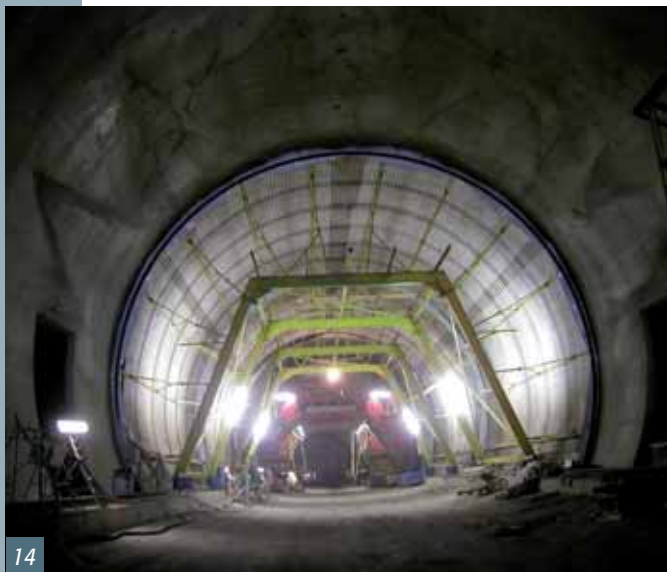
Obr. 14 Ošetřování mladého betonu Fig. 14 Curing of young concrete
