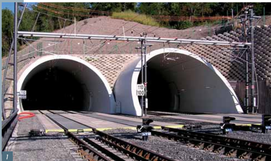
Obr. 1 Pohled na západní portály tunelů Fig. 1 West tunnel portals
