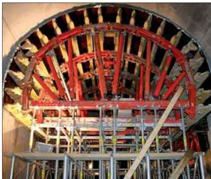
Obr. 6 Betonáž klenby technické komory
