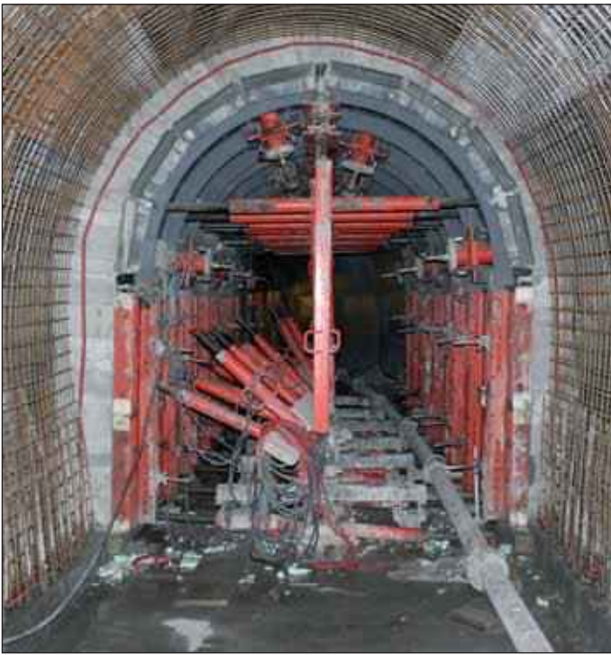
Obr. 2 Betonáž definitivní konstrukce kolektoru Fig. 2 Casting of the final structure of the cable tunnel
